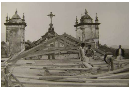
Figura 14. Colocação das tesouras.
