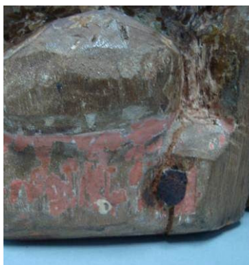
Figura 96. Cravos oxidados na base e rachadura. Fotos: Cláudio Nadalin, dez/2011.
