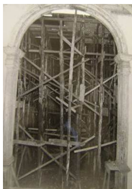
Figura 12. Vista interna, escoramentos e andaimes.
