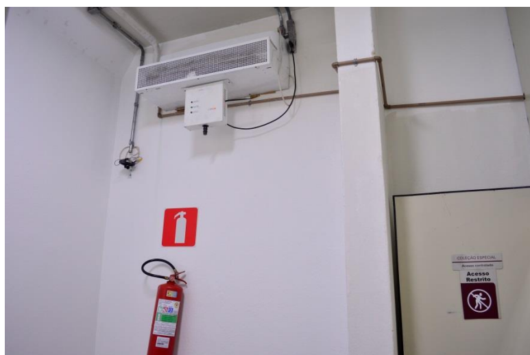
Figura 44: Sistema de ar condicionado, o sistema de monitoramento Climus e um sistema de CFTV na sala de coleções Especiais e obras raras que abriga as coleções “A” e “B”.
