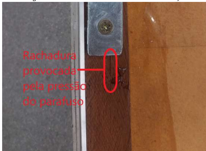
Figura 48 - Detalhe da rachadura na estrutura de reforço.
