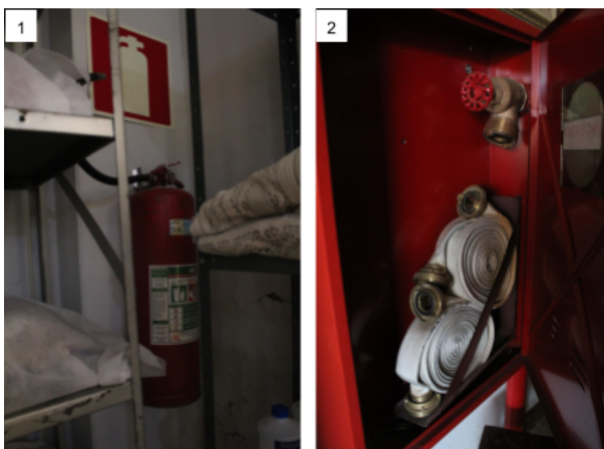
Figura 10 - Extintor A e hidrante de parede
