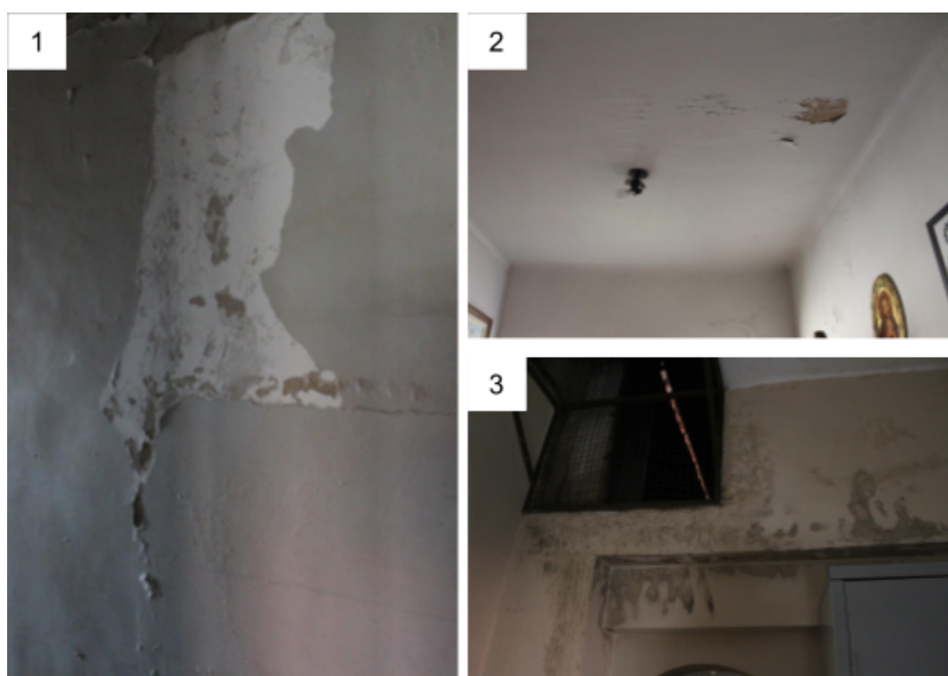
Figura 18 - Infiltrações no edifício do convento
