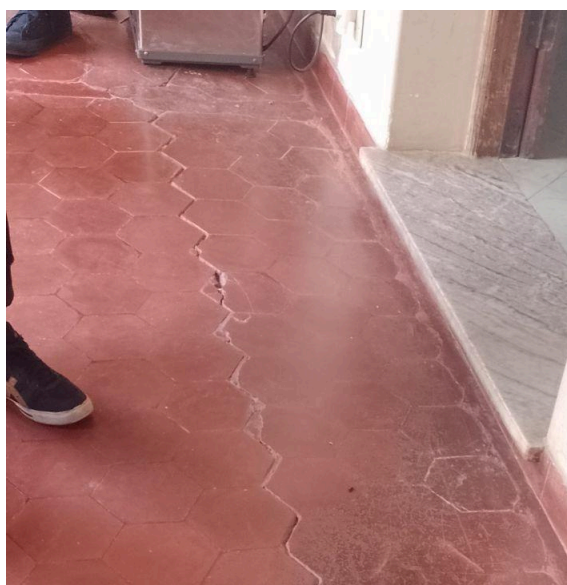
Figura 4 - Rachadura no piso do claustro criada pela infiltração da água da piscina
