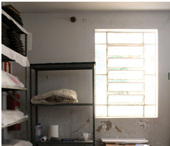
Figura 19 - Infiltração na reserva técnica
