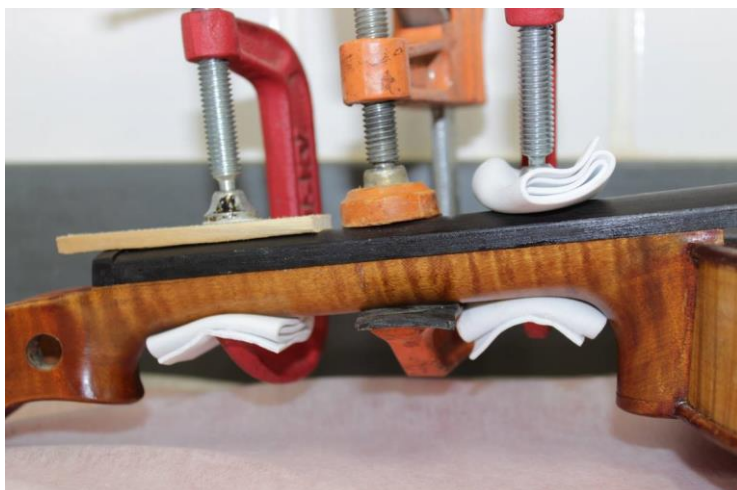
Figura 98 -Intervenções realizadas: Colagem da pestana superior e do espelho no braço. Fotografia: Laura Fiorini
