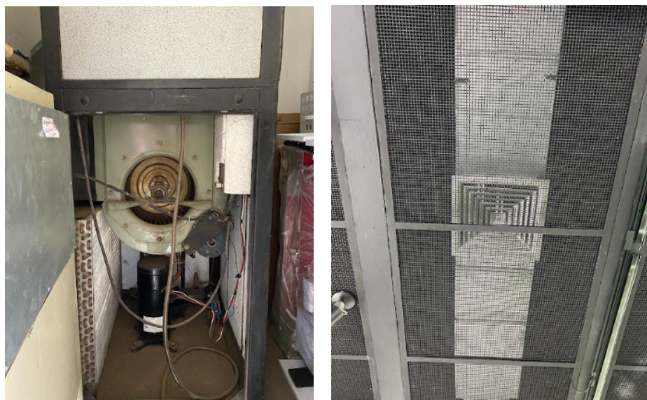
Figura 25 e 26. Compressor do sistema de ar condicionado e registro de uma das seis saídas de ar no interior da galeria.
