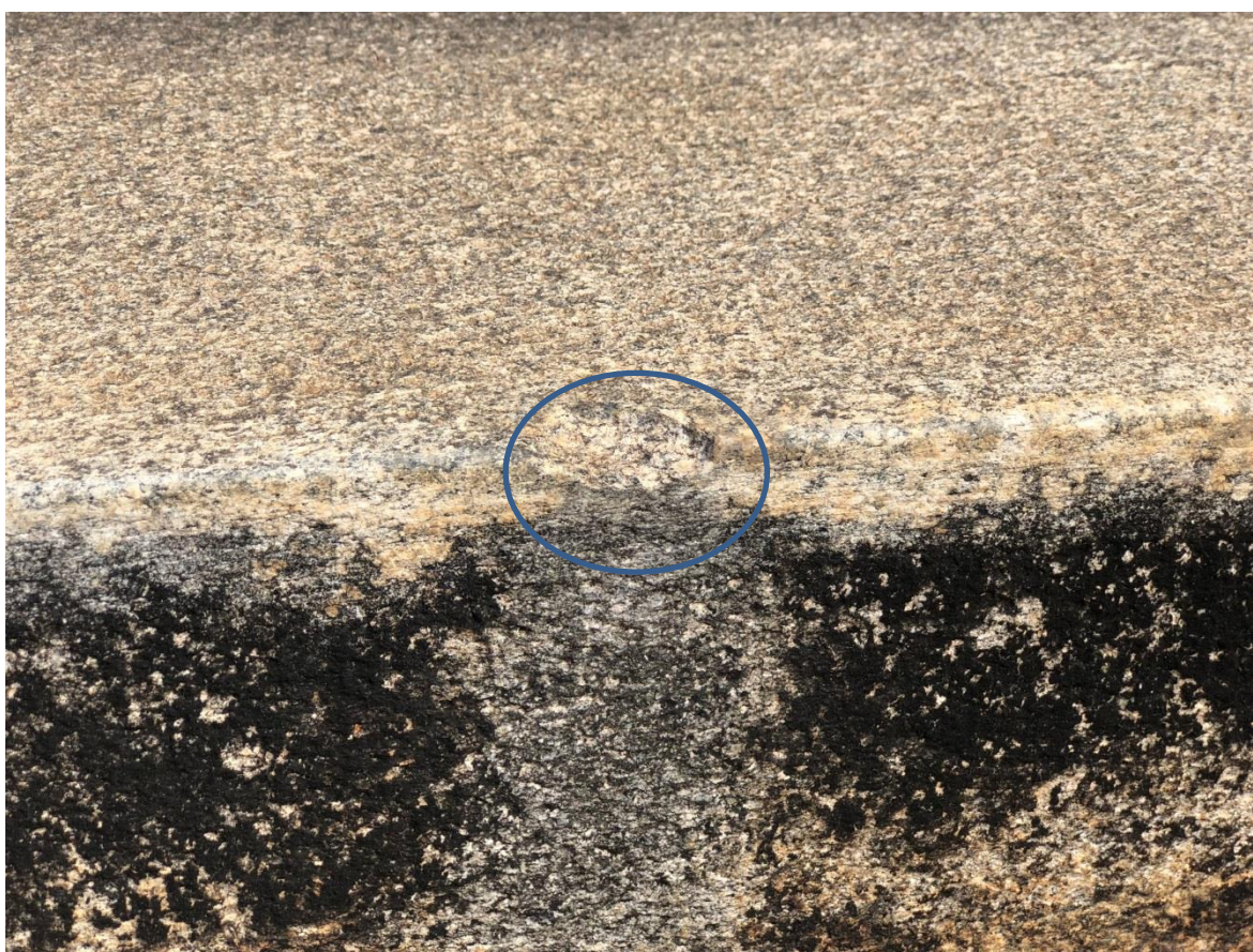
Figura 46: Perda de material pétreo em uma quina do monumento.
