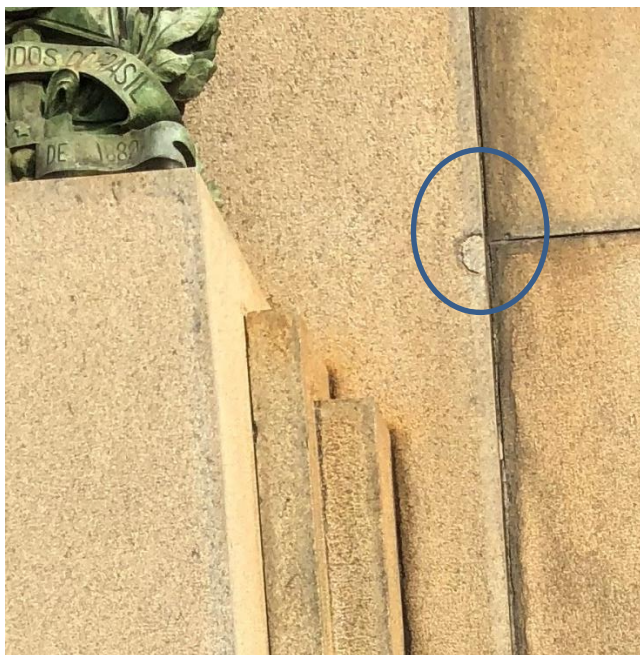
Figura 45: Perda de material pétreo e reposição com provavelmente o pedaço que se desprendeu.
