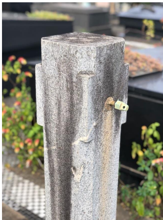
Figura 24: Falta da peça em bronze. Foto da autora
