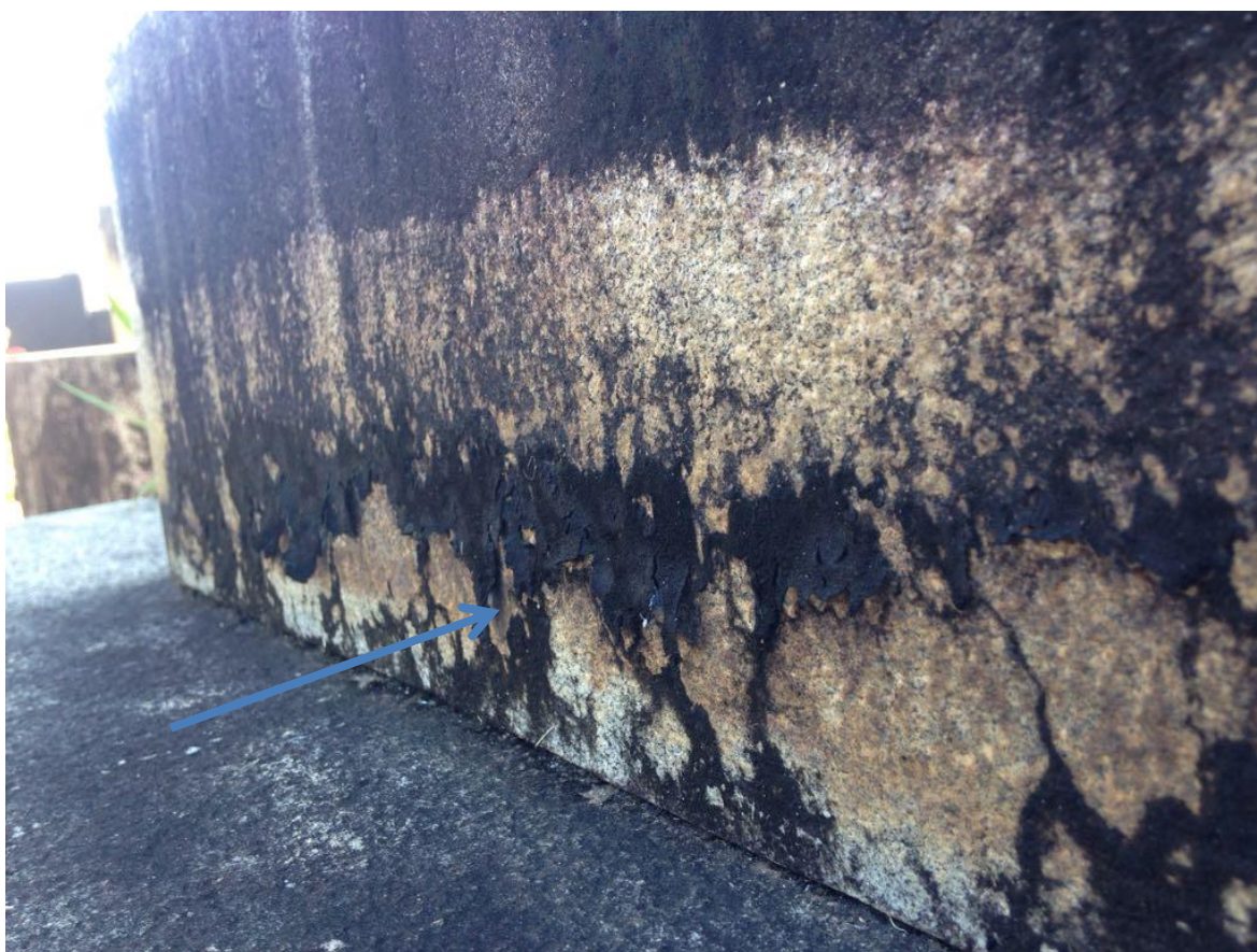
Figura 41: Camadas de crosta negra se soltando da pedra.
