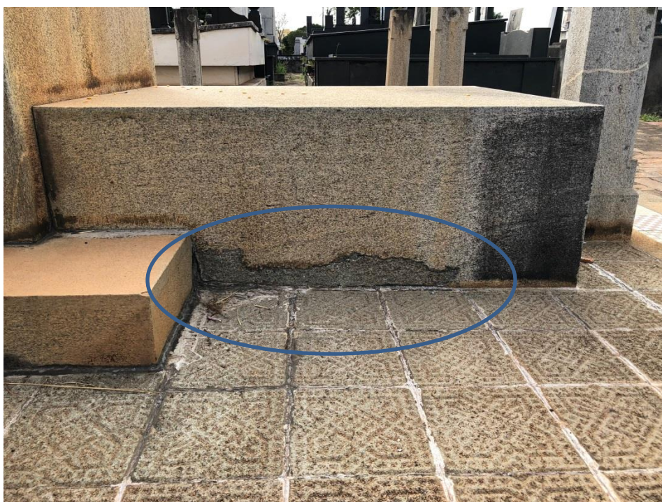
Figura 44: Perda de material preenchida com argamassa.
