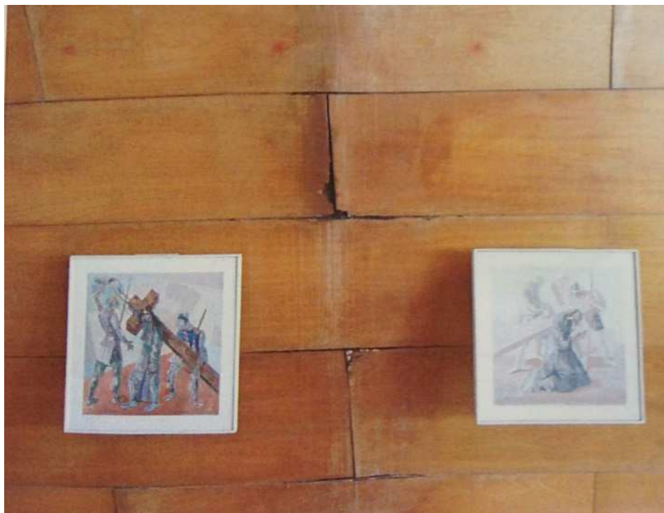
Figura 5 -detalhe da parte mais comprometida da junta, danificando o revestimento próximo aos quadros da Via-Sacra. Relatório Fotográfico IPHAN, 2009.
