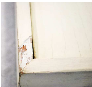
Figura 50 - Área de perda de camada pictórica da moldura, lateral inferior esquerda. Foto: Tereza Moura em 12/08/2019.
