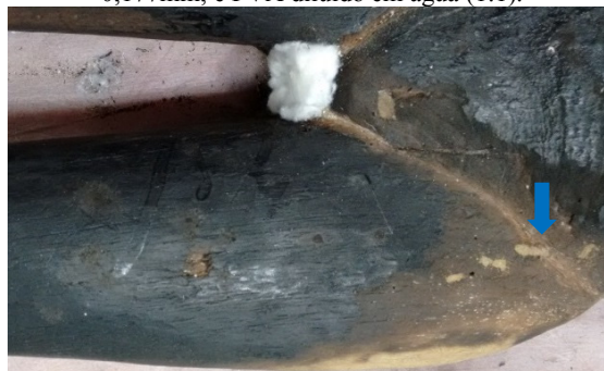
Fotografia 107 – Detalhe da obturação das galerias com massa não pigmentada de serragem fina, peneira de 0,177mm, e PVA diluído em água (1:1).
