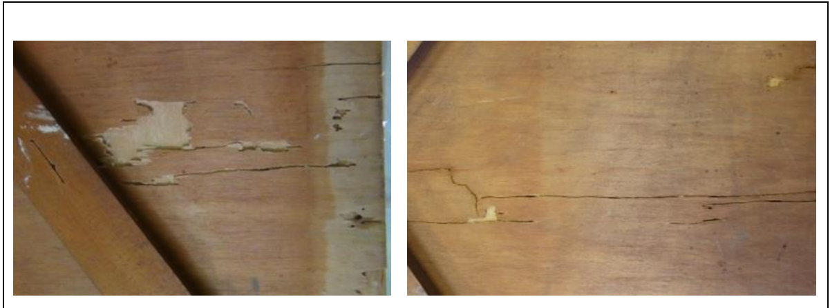
Figura 20- Galerias no suporte (compensado de madeira) devido ao ataque de cupins.
