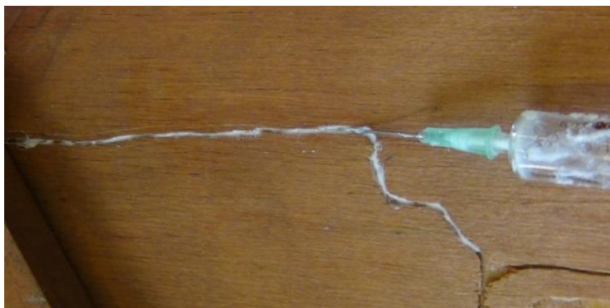
Figura 41 - Consolidação com microesfera e Paraloid B72® com a seringa.
