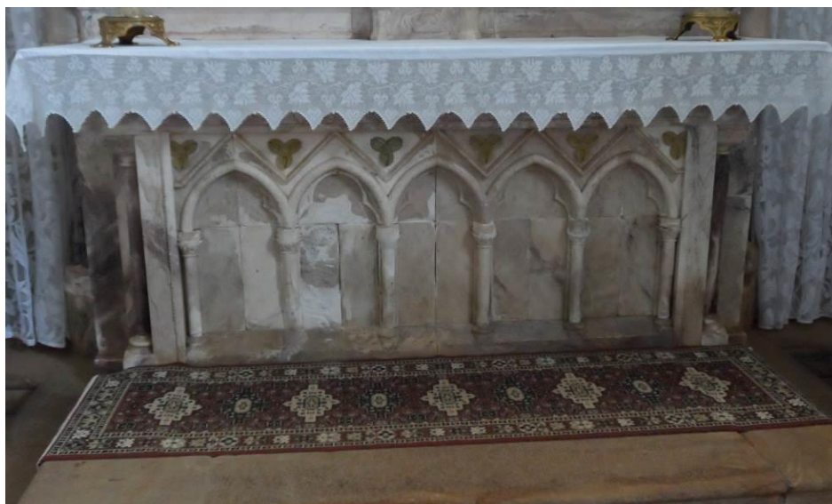
Figura 61: Mesa do altar mor em mármore, da Igreja Nossa Senhora Mãe dos Homens- Santuário do Caraça. Detalhe do fenômeno de deterioração por eflorescência salina. Foto: Maria Clara Assis, 2015.
