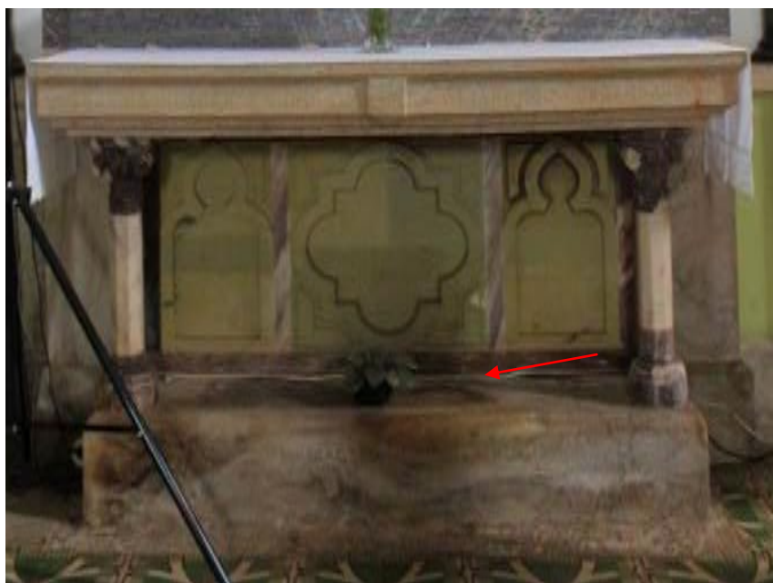
Foto 06 – Detalhe da mesa do retábulo manchas de microrganismos e umidade. Foto Maria Clara Assis.
