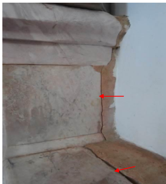
Foto 07 – Detalhe da parte superior do altar da imagem de São Paulo área de descolamento entre o bloco e parede. Foto Maria Clara Assis.
