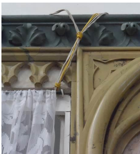
Figura 67: Detalhe da fiação exposta presente nas laterais do altar mor. Foto: Maria Clara Assis, 2015.
