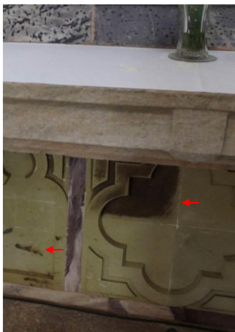
Foto 05 e 06 – Detalhes do retábulo da Imagem de São José, manchas enegrecidas e mancha de umidade ascendente na parede. Foto Maria Clara Assis.
