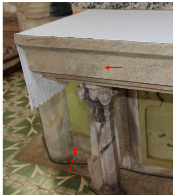
Foto 05 e 06 – Detalhes do retábulo da Imagem de São José, manchas enegrecidas e mancha de umidade ascendente na parede. Foto Maria Clara Assis.
