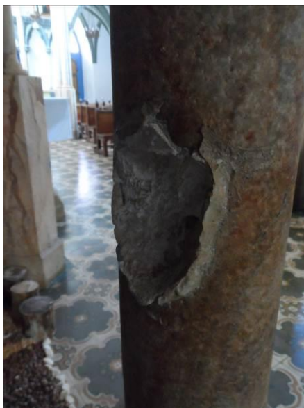
Figura 64- Detalhe do orifício causado pela ruptura da pia de água benta do lado direito do transepto. Foto: Maria Clara Assis, 2015.
