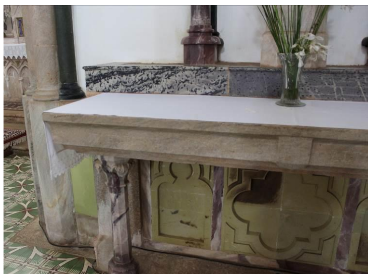
Figura 63: Mesa do retábulo de São José, crosta enegrecida presente no revestimento em pedra na parte inferior do mesmo. Foto: Maria Clara Assis, 2015.
