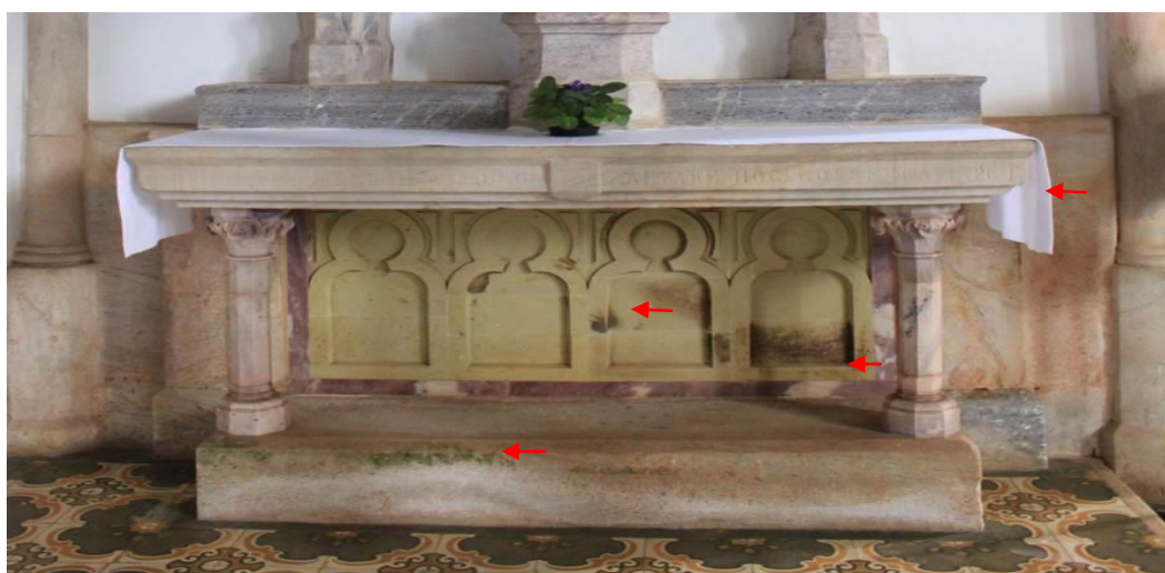
Foto 06 – Detalhes do retábulo da Imagem de São Vicente de Paulo, manchas esverdeadas e proveniente liquens favorecidos pela presença de umidade, manchas enegrecidas e alaranjadas. Foto Maria Clara Assis.
