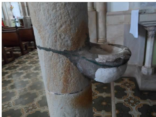
Figura 65: Detalhe da complementação realizada anteriormente para conter a pia de água benta. Foto: Maria Clara de Assis, 2016.
