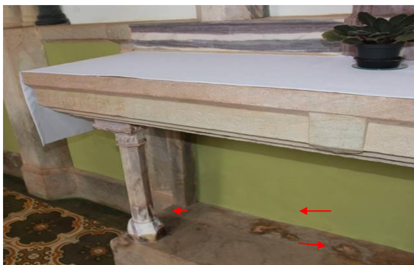
Foto 06– Detalhe do Altar da Imagem de São Francisco de Sales, manchas de umidade e coluna esquerda com estado de eflorescência salina avançada. Foto Maria Clara Assis.
