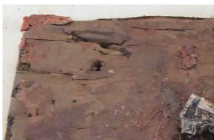
Figura 40 - Perdas causadas por insetos xilófagos em ataque ativo. Foto: Flávia Melo 2012.
