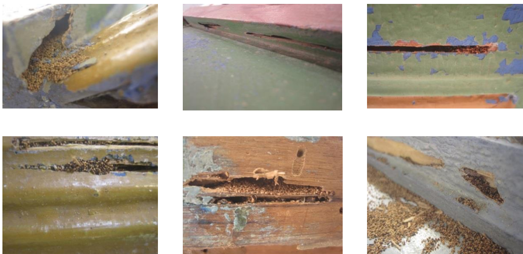
Figura 18: Detalhes mostrando a prospecção de galerias com excrementos de insetos acumulados (Fotos: Leticia Diniz)
