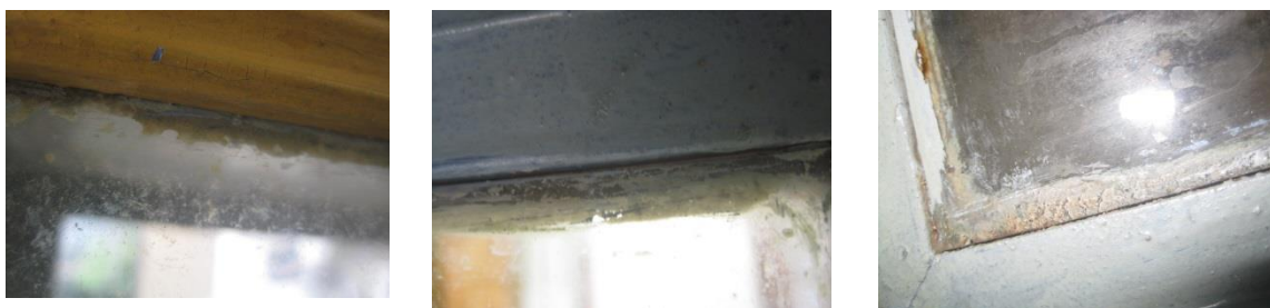
Figura 15: Detalhes mostrando sujidades e resíduos de adesivo e tintas nas bordas dos vidros (Fotos: Leticia Diniz)
