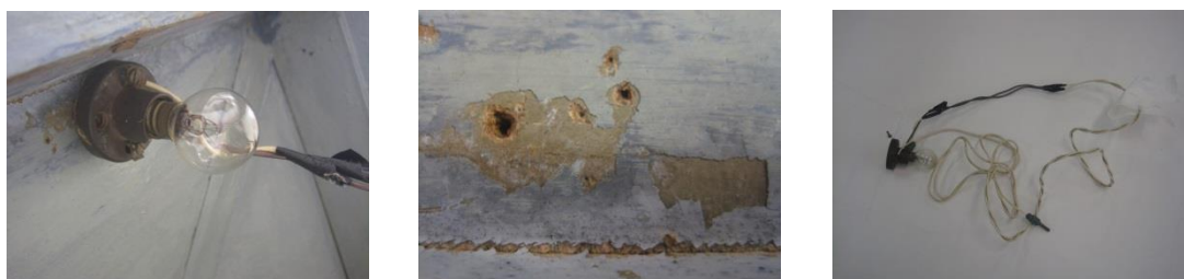
Figura 44: remoção de instalação elétrica da cúpula do oratório (Fotos: Leticia Diniz)
