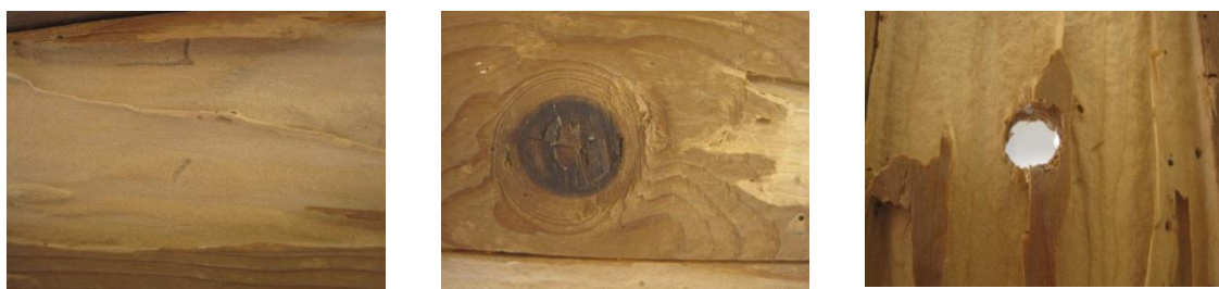
Figura 17: Detalhes mostrando a madeira deteriorada no fundo, o nó da madeira preservado e o orifício para passagem de instalação elétrica (Fotos: Leticia Diniz)
