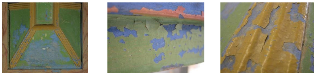
Figura 19: Detalhes mostrando a camada de repintura em desprendimento (Fotos: Leticia Diniz)
