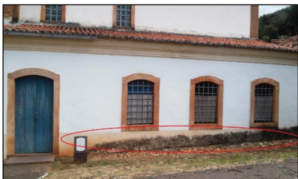
Figura 30. Área externa do Museu, círculo vermelho destacando o terreno da igreja ligeiramente rebaixado de acordo com a calçada pavimentada com pedra, e ainda no círculo é possível perceber manchas causadas pela água e por ataque de microrganismos
