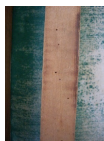
Orifícios que indicam a infestação de insetos xilófagos.
