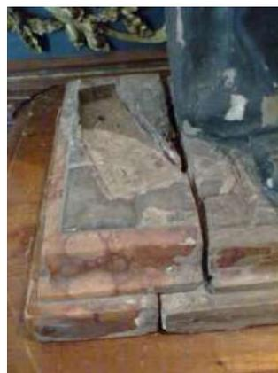
*Figura 08 – Imagem mostra o local para encaixe o pássaro, e o deslocamento do bloco do suporte de madeira. Fonte: Giovana Marcon, 2012.*
